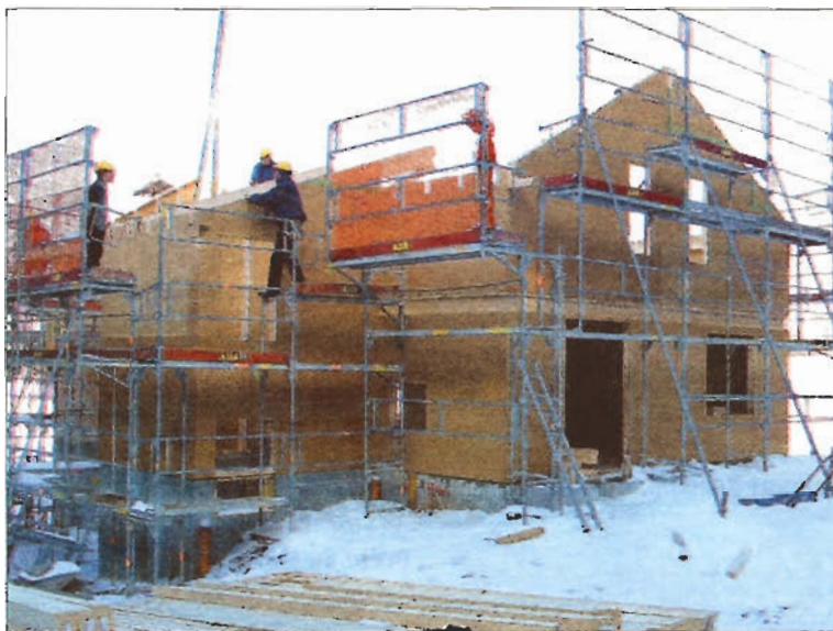
In wenigen Wochen fällt in der Schiessanlage Erlenacker, deren Baubeginn am 5. Januar erfolgt war, der erste Schuss. (Bild: Zaugg)
